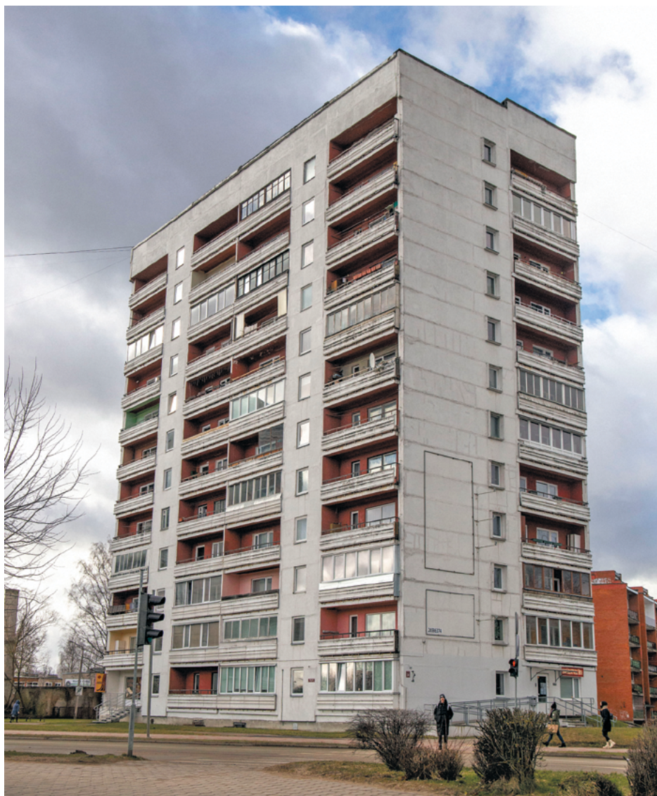
Māja Pasta ielā 34, kas, iespējams, būs pirmā 12 stāvu siltinātā māja Latvijā
