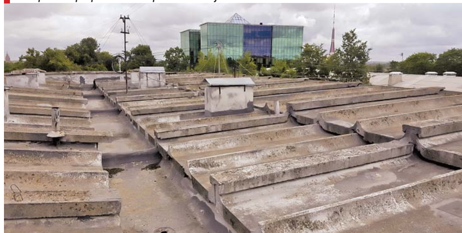
Jumts pirms un pēc pārklāšanas ar poliuretānu mājai Garozes ielā 19
