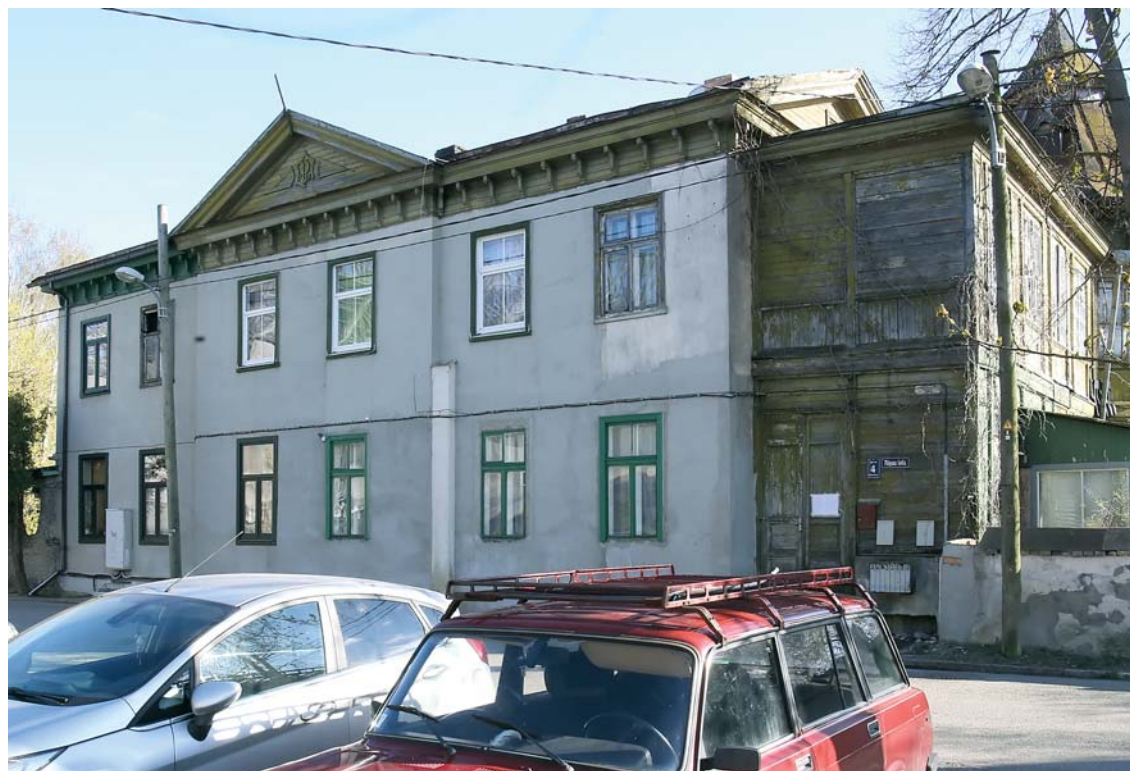
Par nesaskaņotu fasādes remontu aktīvākie mājas iedzīvotāji 2011. gadā saņēma sodu. Tagad remontu tiek veikti tikai pēc noteikumiem.
